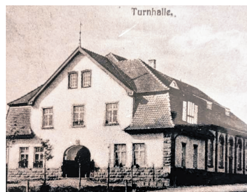
Mit dem Bau der Turnhalle Keimstraße 1909 wurden geräumige Möglichkeiten geschaffen
